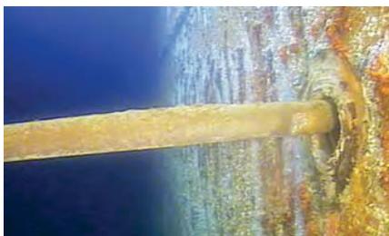
Coroziune descoperită pe pereții rezervorului
