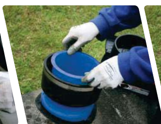
Pozitionati manseta de de fixare, atentie la sagetile indicatoare
