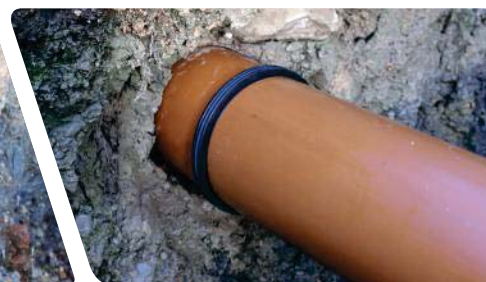
Impingeti a doua teava din partea opusa Asigurati-va ca buza de cauciu a garniturii nu se pliaza sau este prinsă cand impingeti teava.
