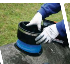
Introduceti buca de cauciuc in mansoul de cuplare din EPDM
