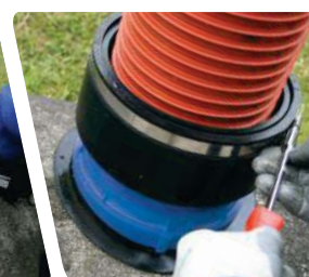
Strangeti colierul de INOX cuplu de 6 Nm
