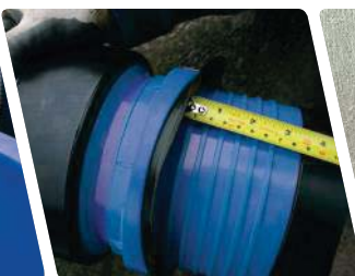
Ajustati filetul racordului la grosimea de perete
