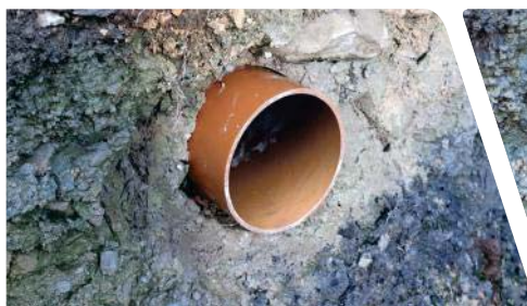
Se curata interiorul tevii de namol si impuritati.
